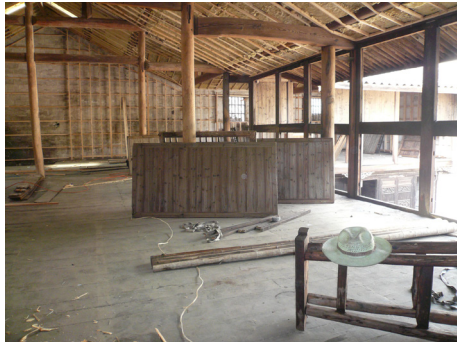
Maison d'hôtes à Lizhang, en chantier, 2008
